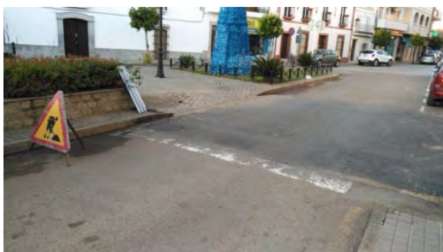
Trabajos de construcción de un paso elevado en c/ Pilar
