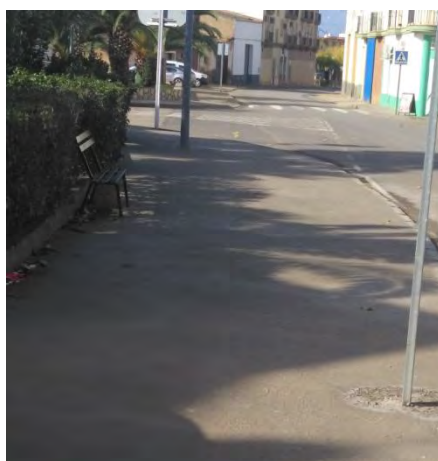
Arreglo en zona de C/ San Blas
